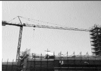
Il cantiere per la costruzione della nuova chiesa di San Giovanni Battista de La Salle
