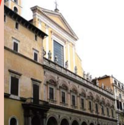
Una veduta della facciata della basilica dei Santi Apostoli
