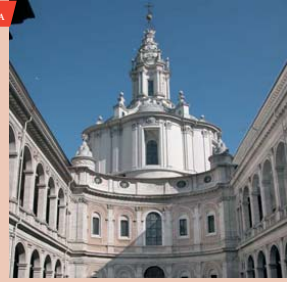
La facciata della chiesa di Sant'Ivo alla Sapienza realizzata da Borromini
