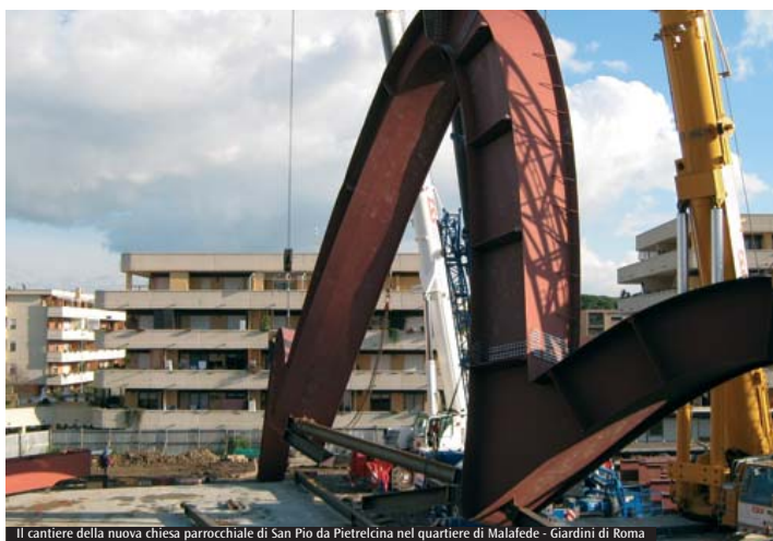
Il cantiere della nuova chiesa parrocchiale di San Pio da Pietrelcina nel quartiere di Malafede - Giardini di Roma
