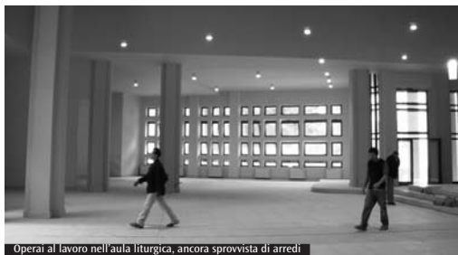
Opera al lavoro nell'aula liturgica, ancora sprovvista di arredi
