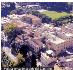
Veduta aerea della sede del Gianicolo
